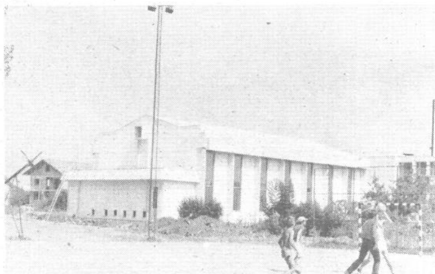
Posnetek je z Iga, kjer je v zaključni fazi izgradnja prizidka k osnovni šoli – to je telovadnice
