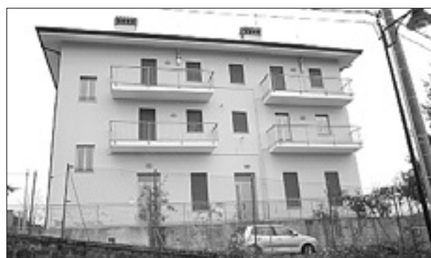
Stanovanjski blok v Grajski ulici
