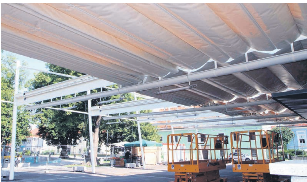
Podobno veliko prahu, kot ga je pred leti dvigoval projekt gradnje fontane, je v minulem letu dvigovalo tudi nadkritje tržnice v njeni neposredni bližini. Projekt so spremljale številne težave, podražitev in večkratna prestavitve roka dokončanja. Ko so prenovljeno tržnico končno vendarle odprli, se je pokazalo tisto, na kar so mnogi opozarjali že pred gradnjo – da streha pušča. To so uspeli vsaj za zdaj uspešno popraviti. Upamo, da bo streha še dolgo služila svojemu namenu.
