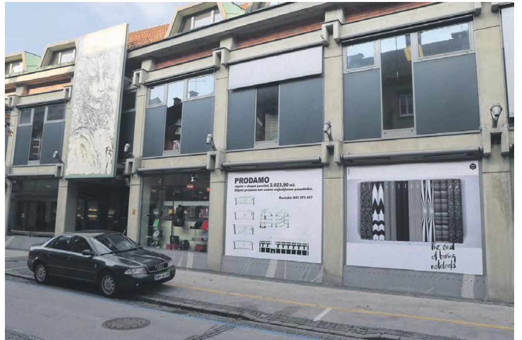
Največ sapa je lani mnogim v Celju vzela vest o tem, za koliko je bila prodana stavba propadlega podjetja Leonardo v središču mesta. Zgradbo, ocenjeno na malo manj kot dva milijona evrov, je namreč kupcu iz Grosupljega uspelo dobiti le za približno pol milijona evrov.
