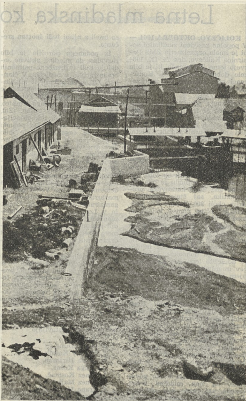
Medvode — Fotografija kaže del starega obrata naše poslovne enote. Poleg tega pa je lepo viden odtok industrijskih voda v kanal. To je stalen, čeprav včasih neopravičen, kamen spotike. Zadeva se sicer postopno izboljšuje, verjetno pa bo sedimentacijski bazen precejšen pripomoček pri tem (V. B.)
