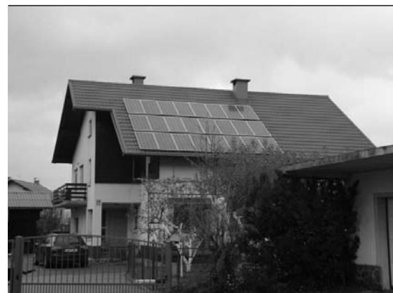
Mala sončna elektrarna na strehi
