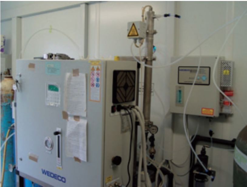
Slika 4: Generator ozona, analizator ozona v odpadnem plinu ter destruktor prebitnega ozona v plinasti fazi
