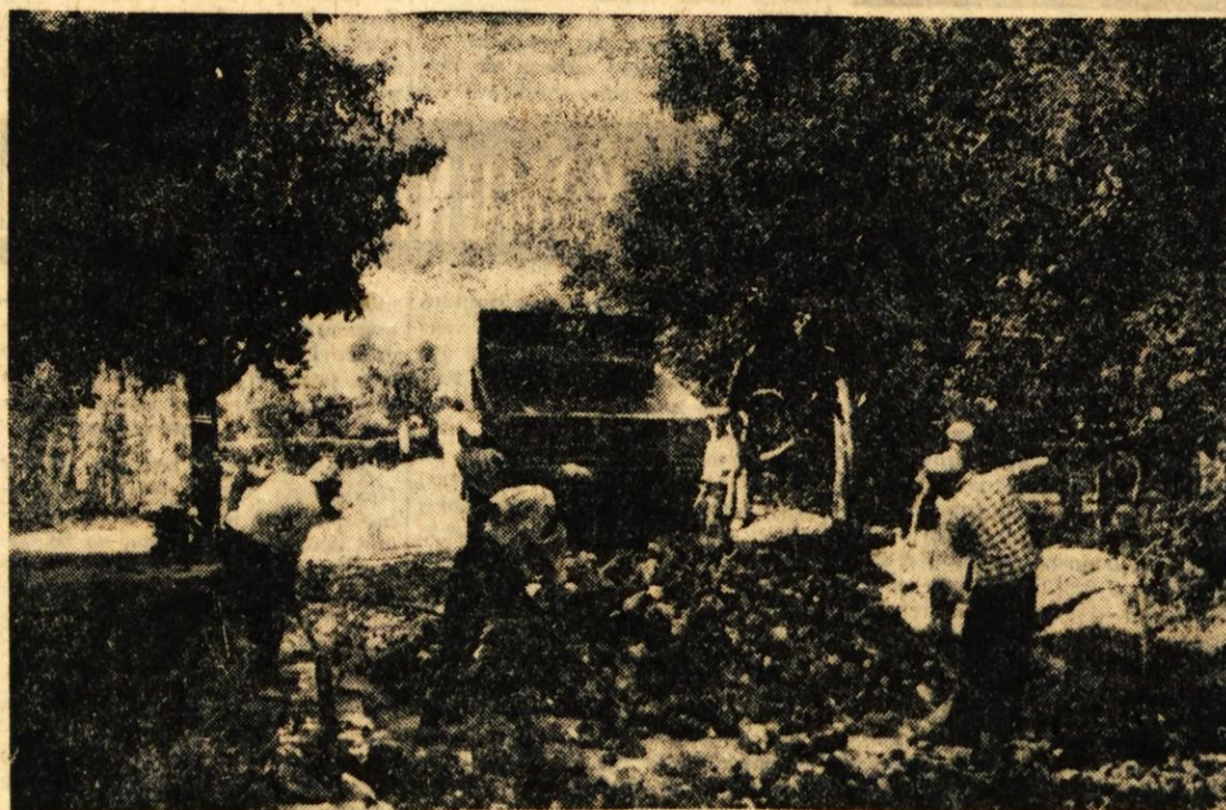
Asfaltiranje ceste med Bledom in Ribnem lepo napreduje. Prvi del cestišča bo asfaltiran verjetno že v tem mesecu, deli na drugem pa bodo verjetno nadaljevali spomladi.
