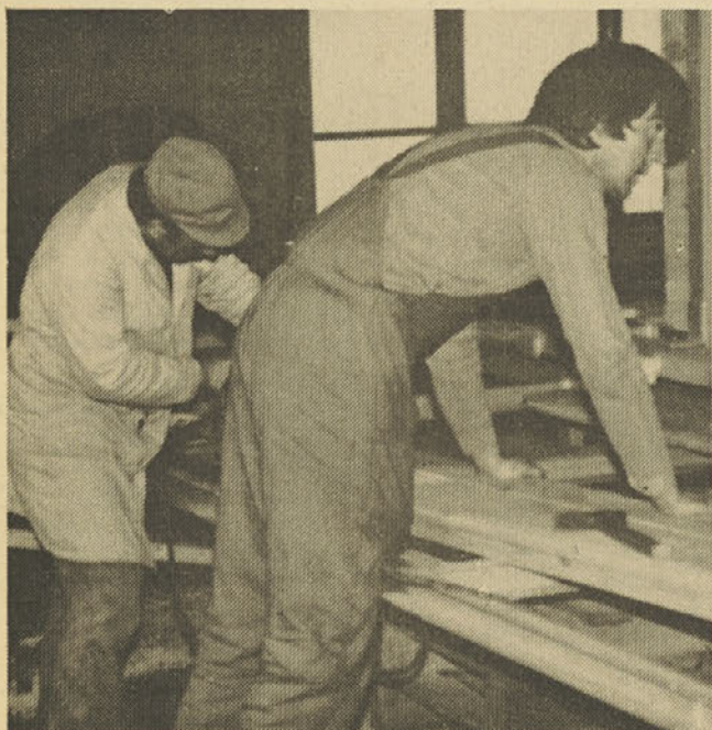
Postavitev opaža delovnega odra je bilo eno izmed mnogih del, ki so ga opravili s »serviserji«.
