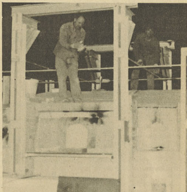
Še zadnja šamoterska dela na že prižgani peči. (vse foto Z. Novak)
