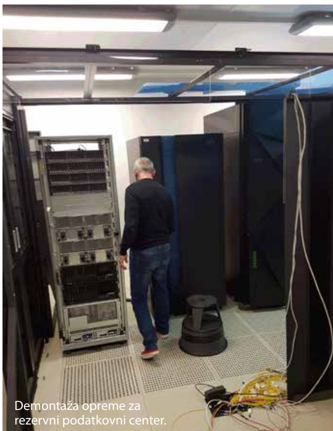
Demontaža opreme za rezervni podatkovni center.
