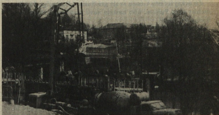
Betoniranje desnega krajnega opornika.
