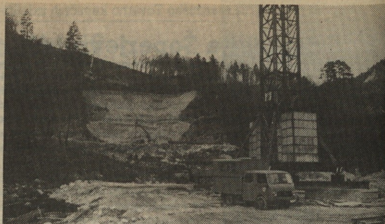
Pogled od vznožja stebrov (visoka bosta po 52 metrov) proti robu police, s katere bo prišla avtocesta iz smeri Blejske Dobrave.
