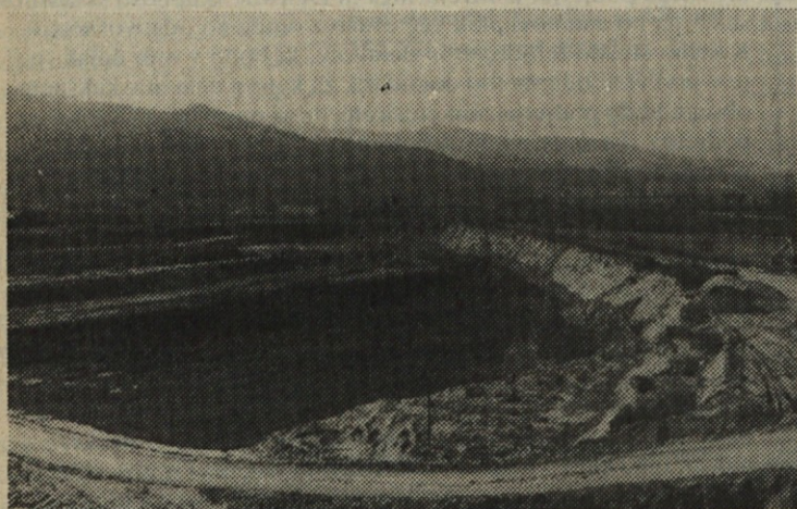
Z istega mesta smo naredili tudi posnetek vtočnega korita, kjer so strojniki že opravili grobi izkop.
