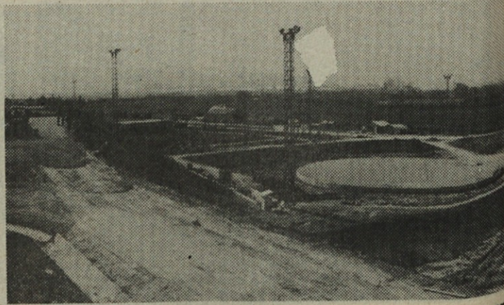
Del požarne ceste v gradnji. Pod njo vidimo podstavek za peti rezervoar. Skupna zmogljivost »skladišča« bo okrog 50 do 60.000 ton goriva.
