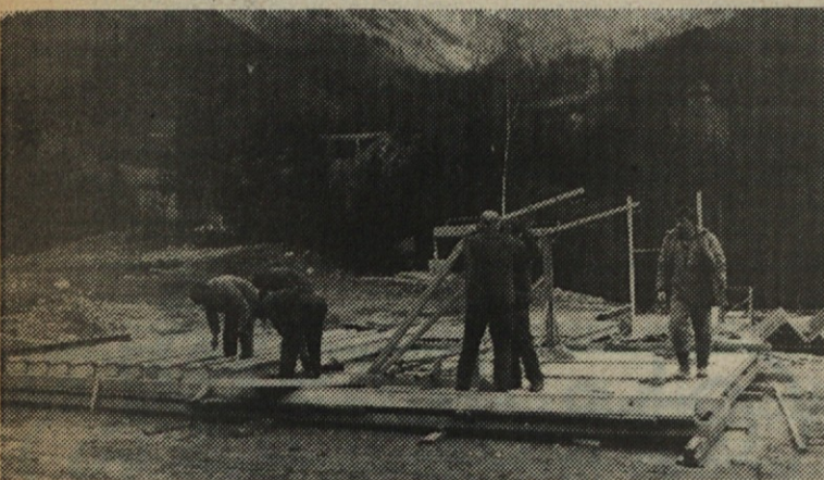
Za ta objekt so Nizkogradjanci v Avstriji kupili nov drsni opaž Doha. Po sestavitvi, so začeli s kontinuirano betonažo – v paru.
