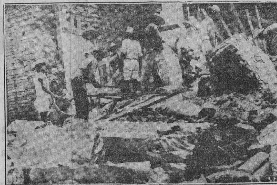
Reševalci raziskujejo razvaline za morebitnim žrtvami. V Colima, Meksiko je divjal potres, ki je zahteval najmanj 174 človeških žrtv in porušil na stotine domov.
