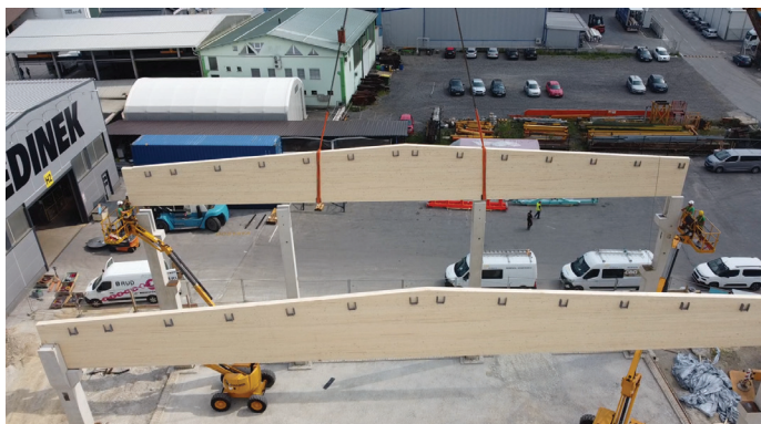
Slika 10. Montaža krajnega lesenega nosilca na armiranobetonske stebre.
