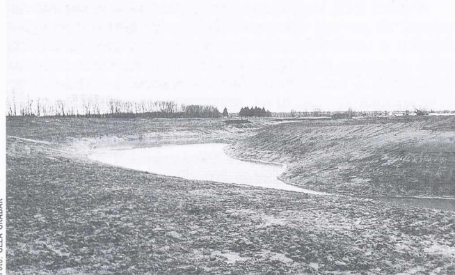
DELA SO ZAUSTAVLJENA – zemljišče na vzhodni strani zdravilišča, ob cesti Moravske Toplice – Tešanovci, je temeljito spremenilo podobo – a za zdaj so dela ostala na pol poti.
