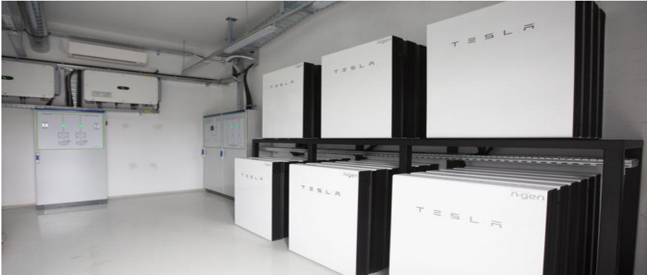
Slika 2: Hranilnik je mogoče namestiti na tla ali steno (Vir: lastni Javeršek, 2025)
