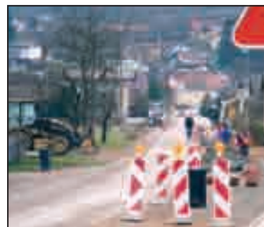
Kanalizacijo na Ljubljanski cesti gradijo hitro in kakovostno.
