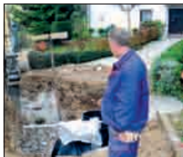
Gradnja kanalizacije Dol - Laze se je dobro začela ...
