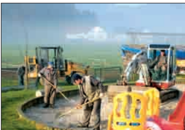
Obnovitvena dela oziroma utrjevalna dela na delu igrišča Vrta Marjetica
