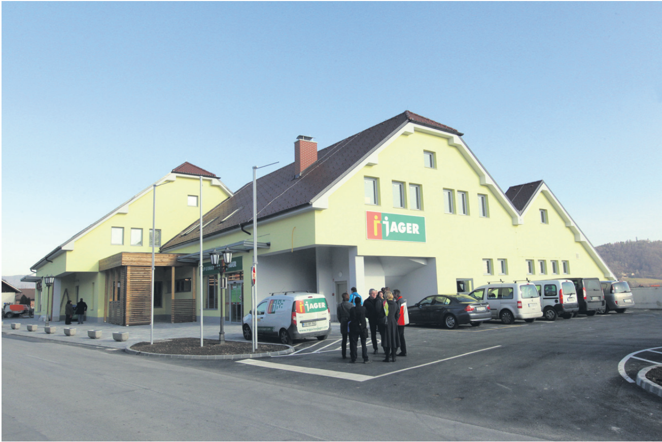
Braslovčani so po treh letih prizadevanj, da bi v središču kraja zrasla večnamenska zgradba, ki bi pod streho združevala tako javne kot zasebne dejavnosti, to le dočakali. Občina in podjetje Jagros sta prejšnji teden še uradno končala gradnjo večnamenskega objekta, v katerem od prejšnjega četrтка delujeta gostinski lokal in trgovina. Do konca leta bo občina v njej uredila še dvorano, knjižnico in prostore za druženje.
