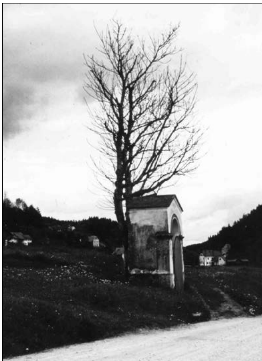
Porušena Marušnkova kapelica v Dobju
