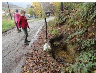
Slika 9: Neustrezno zaščiteni globlji jamo
