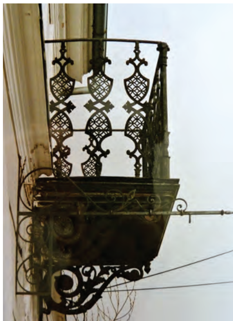
Fototeka ZVKDS, OE Ljubljana, VRHNIKA – mesto F. 115 (9039/št.: Litoželezna ograja s konzoloma na hiši Voljčeva c. 19 pred njeno odstranitvijo; (foto: Mojca Arh Kos)
