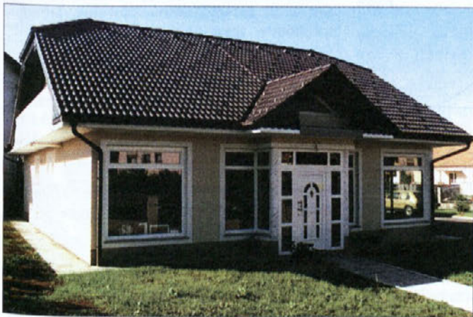
Novi poslovni prostori Montaže Košir v Levca.
