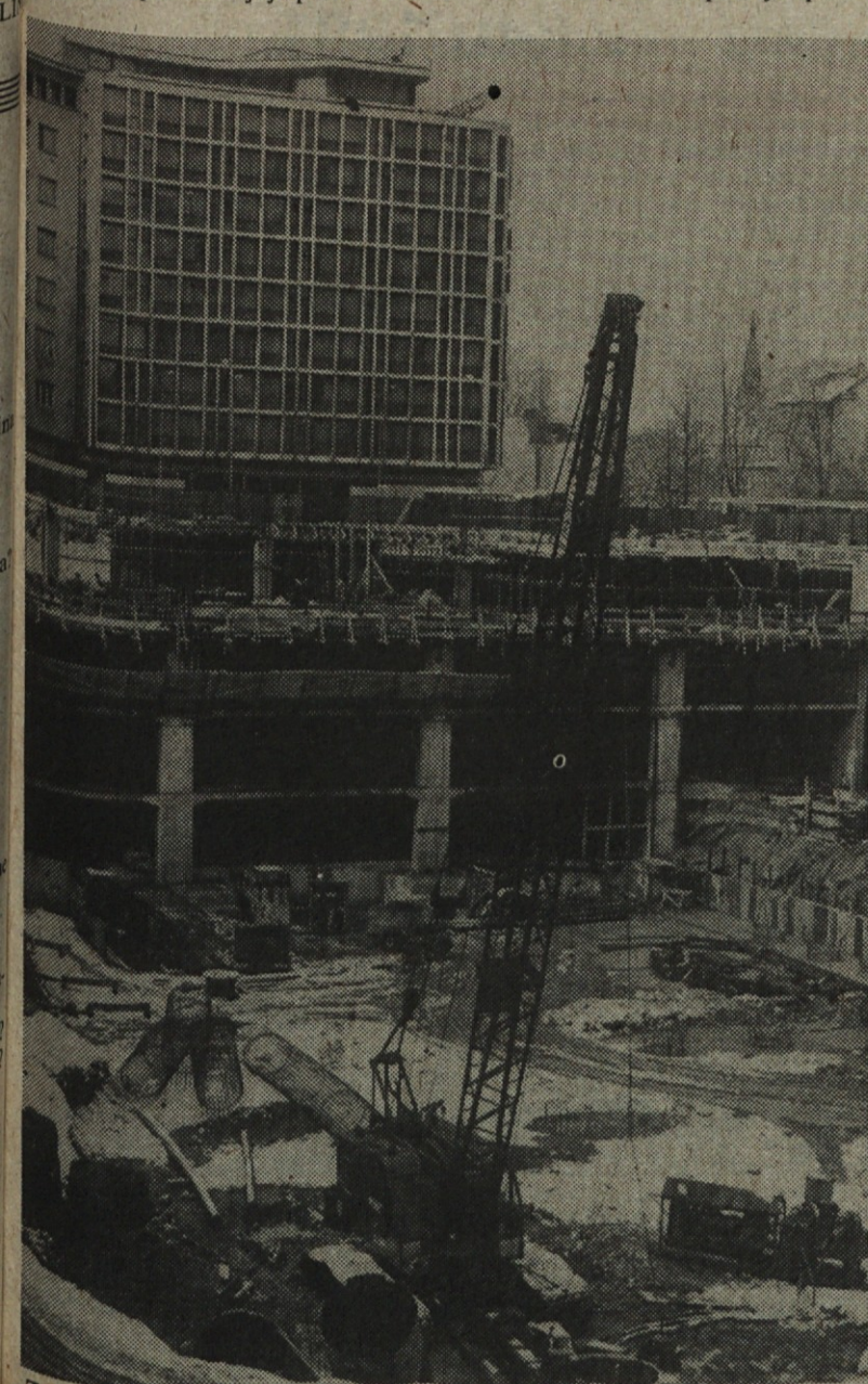
Za gradnjo druge faze PBK je potrebno napraviti 109 pilotov, ker je nosilnost tal dokaj slaba. Pilote dela Geološki zavod. V ozadju se vidi 4 kletne etaže prve faze
