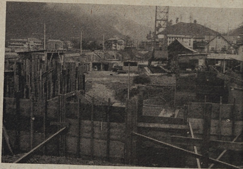
Temelji za tri stanovanjske stolpice na Koroški beli so že narejeni
