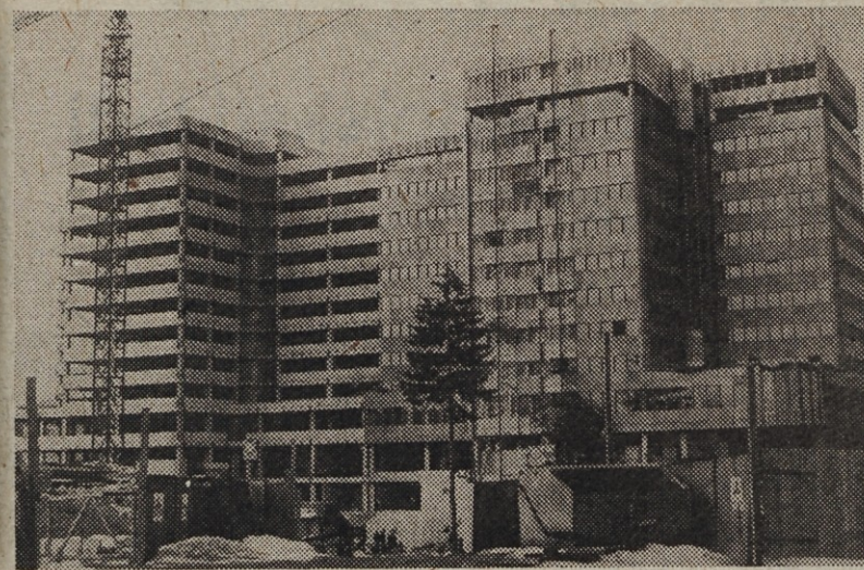
Jeseničani imajo tudi gradbišče v Ljubljani, saj gradijo južni del poslovnega centra Slovenijalesa
