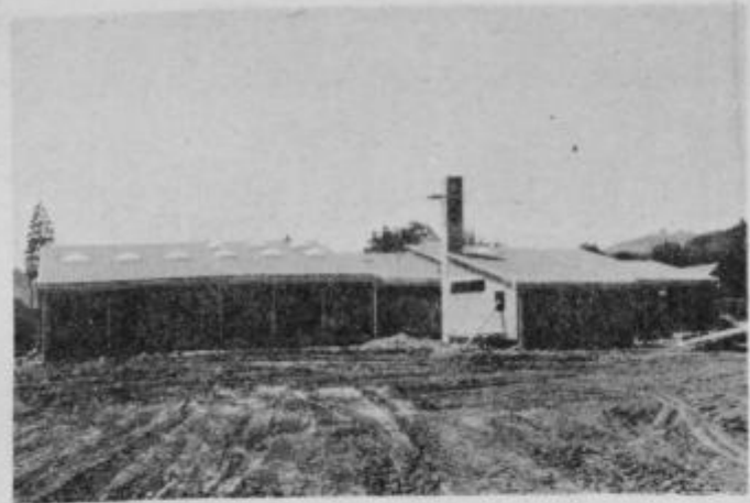
Se zadnja gradbena dela na zgradbi nove osnovne šole na Zg. Polskavi, kjer bo ob prazniku občine svečana seja
