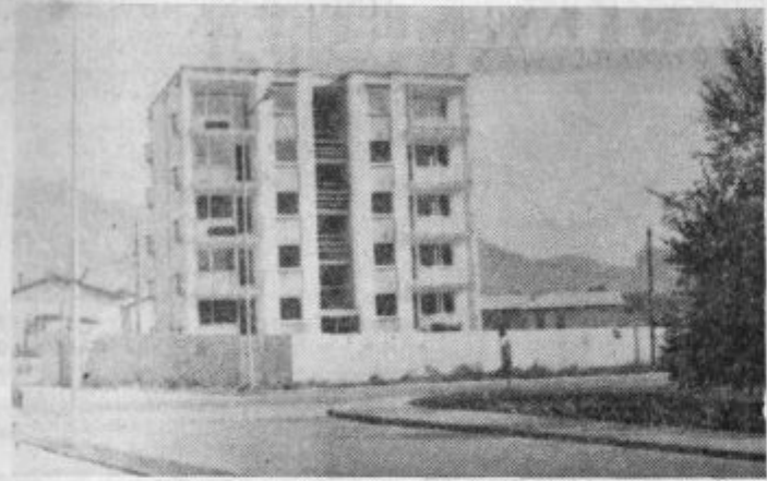
Se to leto se bodo rudarji vselili v stolpiče na začetku Efenkove ceste, ki jih gradi za Rudnik lignita Velenje SGP Vegrad Velenje. Prvi stolpič je na zunaj že urejen
