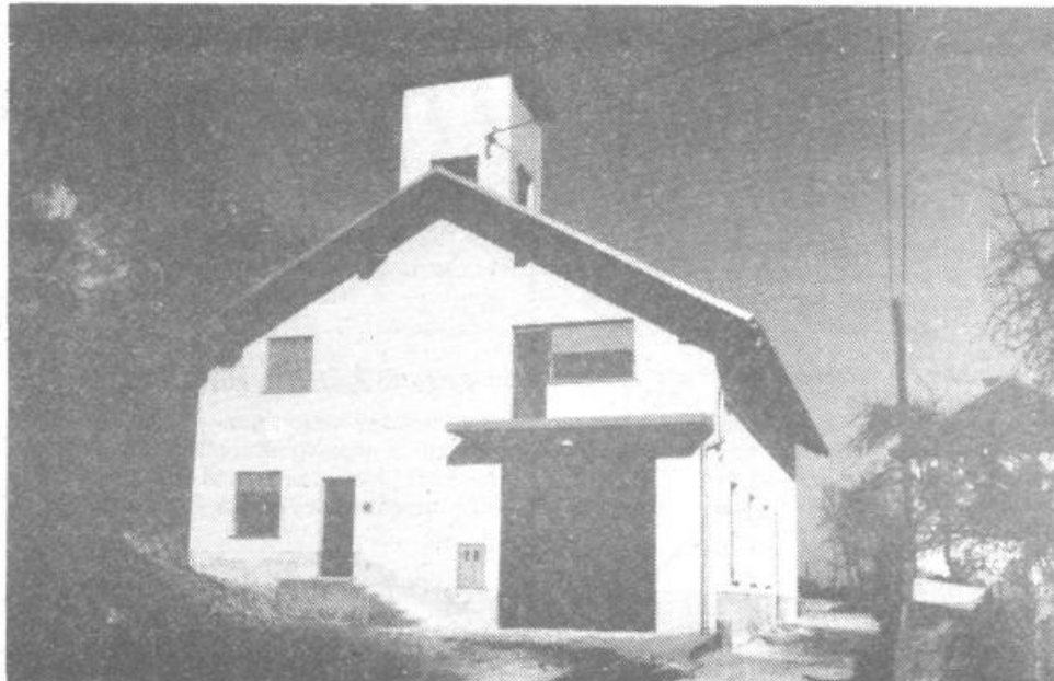
Krajanji Notranjih Goric, predvsem pa seveda gasilci, so skoraj za celo leto prehiteli načrt obnove gasilskega doma. Tako sedaj izgleda povečan in z urejenim pročeljem
