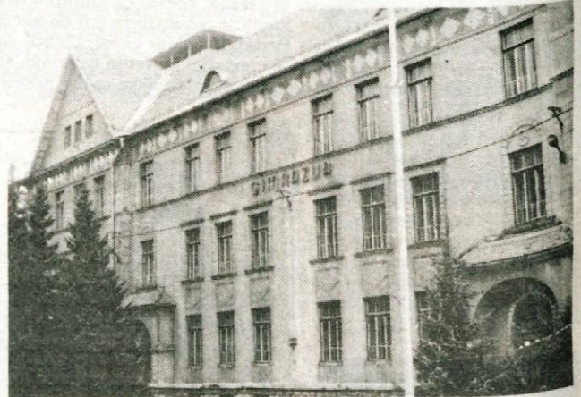
V krajevni skupnosti Sava na Jesenicah je tudi jeseniška gimnazija, ki se pripravlja na obnovo fasade in poslopja... Foto: D. Sedej
