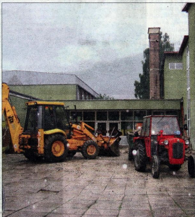
V OŠ Ob Dravinji v teh dneh namesto klepeta solarjev odmeva hrup gradbene mehanizacije.
