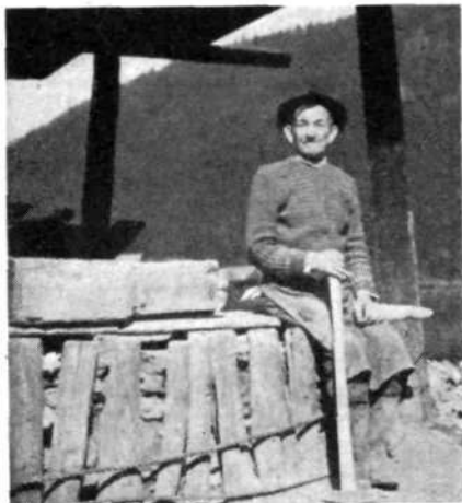
Jaka Pintar kuha že dolga desetletja apno v Jelenčevi apnenici. Lepo je viden oplet iz kostanjevih kolov in železne vezi na apnenici. (Foto A. Ramovš.)
