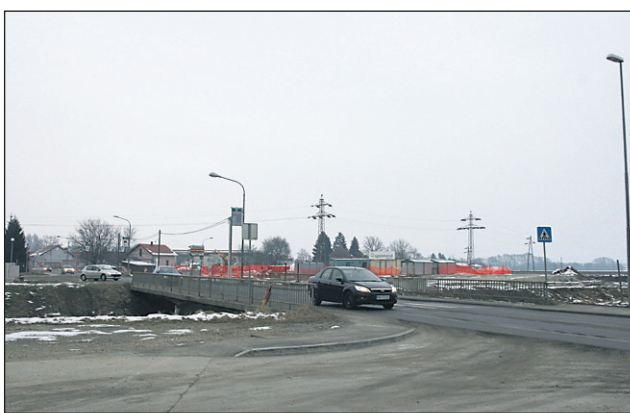
Gradnja novega krožišča poteka nemoteno.
