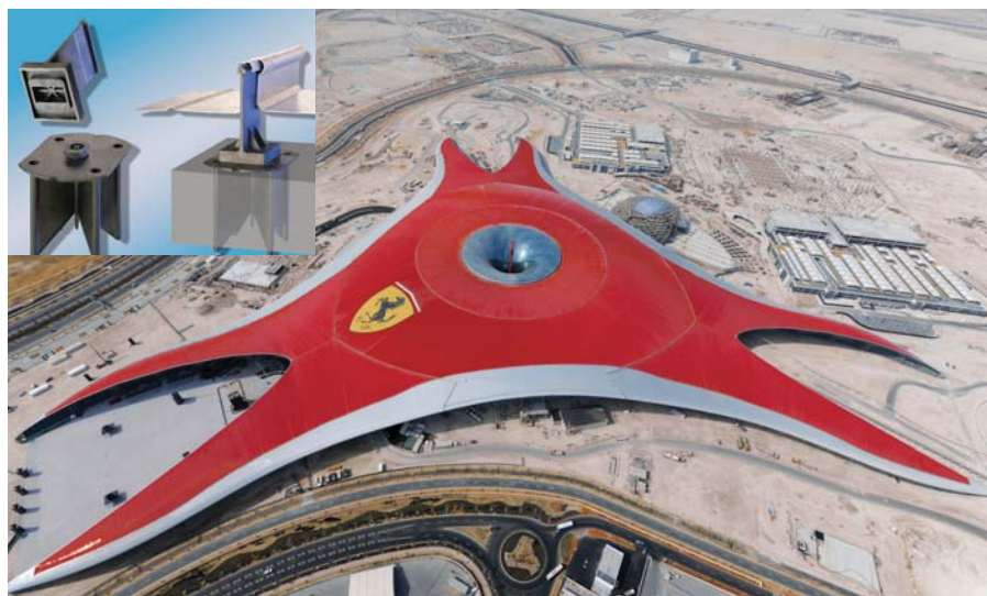
Streha Ferrarija v Abu Dhabiju, podprta z nosilno-montažnimi elementi iz PA 66 – Ultramida (foto: BASF)
