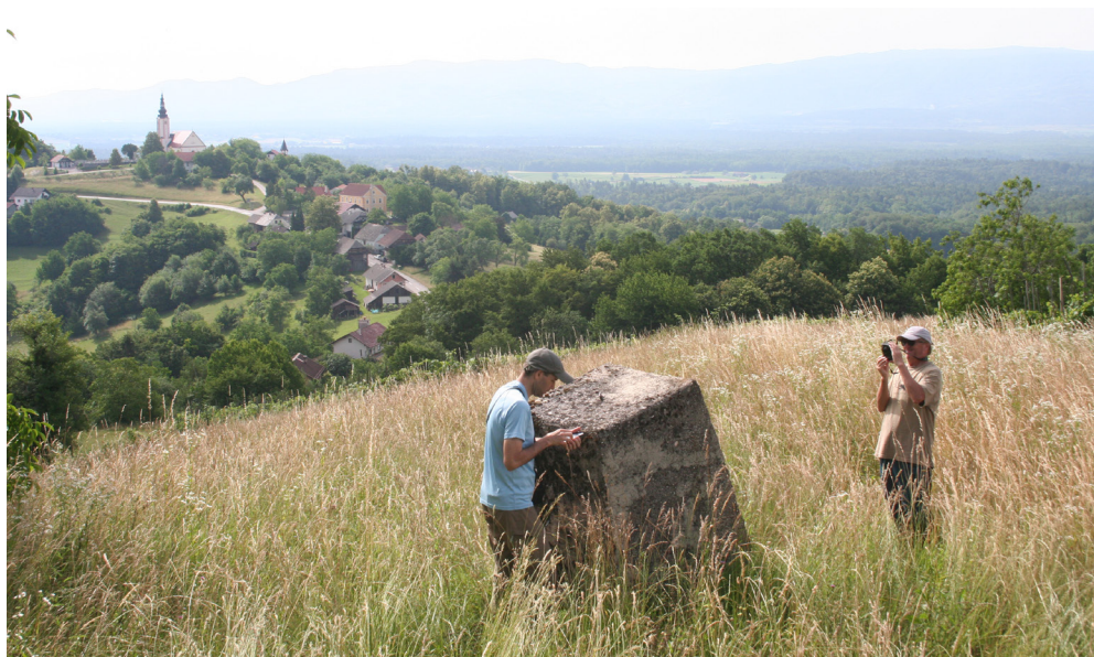
Slika 52: Betonski temelji nemškega stražnega stolpa na Slemenu nad Bučko.
