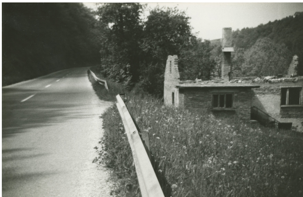
Slika 46: Ruševine nekdanje Murnove hiše v bližini Tržišča, ob cesti Tržišče – Sevnica, okoli leta 1980. V bližini je bila tudi obmejna rampa. Prvotna okupacijska meja je nekaj mesecev potekala slab kilometer proti Tržišču.
