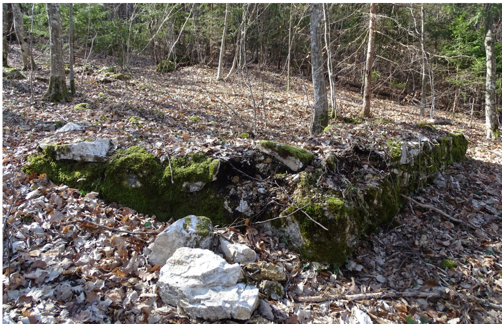
Slika 43: 65 centimetrov debeli ostanki zidu bunkerja na griču Breznik pri vasi Dolž.
