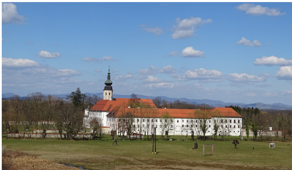
Slika 11 a: Grad Kostanjevica, nekdanji cistercijanski samostan, razpuščen leta 1786, od leta 1974 je v stavbi Galerija Božidar Jakac, Kostanjevica na Krki.
