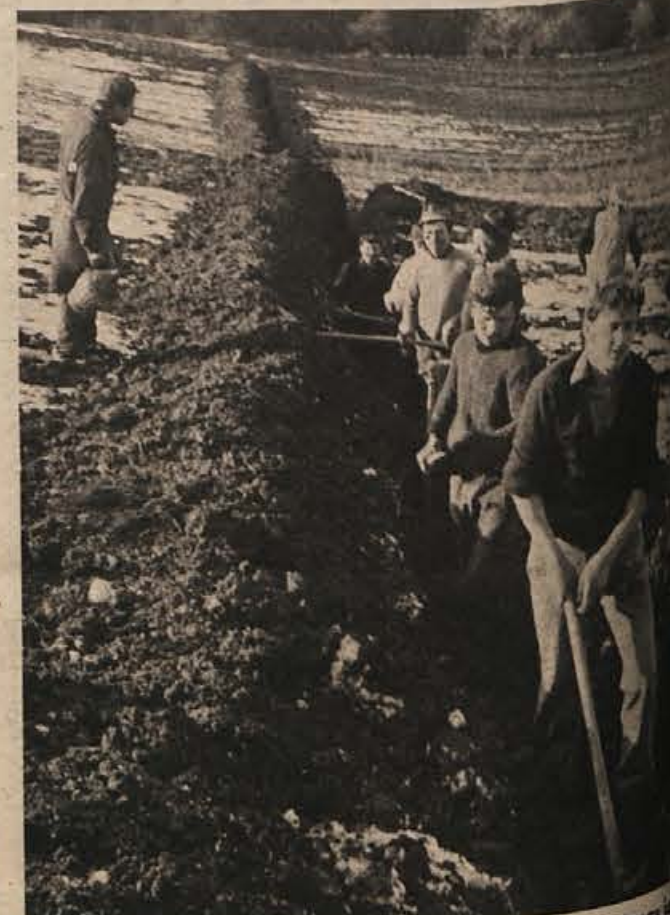
Kodričevi iz Brezja morajo skopati 190 metrov vodovodnega jarka v strmino. Na pomoč so poklicali delavce iz Gradca in s hrvaške strani. Tule na srečo ni skal, niže doli pa se začneja 800 metrov skalnatega sveta, kjer brez minerjev ne bodo nič opravili. (Foto: Jožica Teppey)
