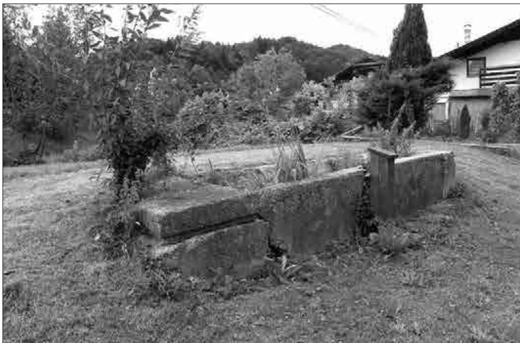
Ostanki betonskih korit za pranje usnja na Adamičevi zemlji (foto: Božena Hostnik).
