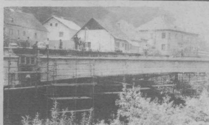
Zadnjega avgusta so delavci Gradisa čez Gruberjev prekop položili zadnji nosilec zahtevne mostne konstrukcije.
