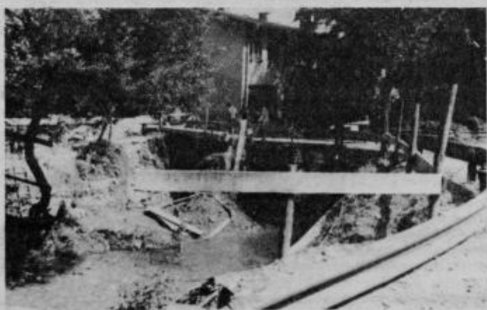
Začetek gradnje novega mostu čez Bistrico
