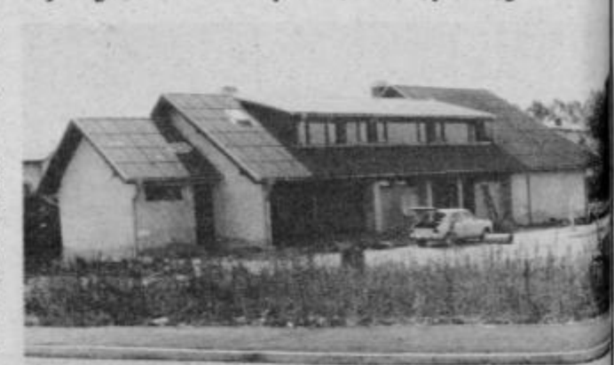
Zaključna dela na domu društev v Ormožu
