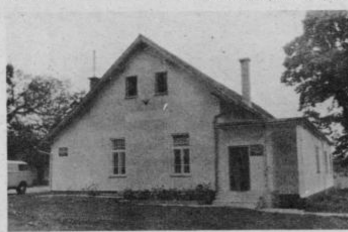
Zgradba v Hajdini, kjer se stekajo vsi družbeni in politični tokovi tega kraja. Desni del je ostanek prvega prosvetnega doma, levo v ospredju pa prizidki v katerih imajo prostore KS in mladina.
