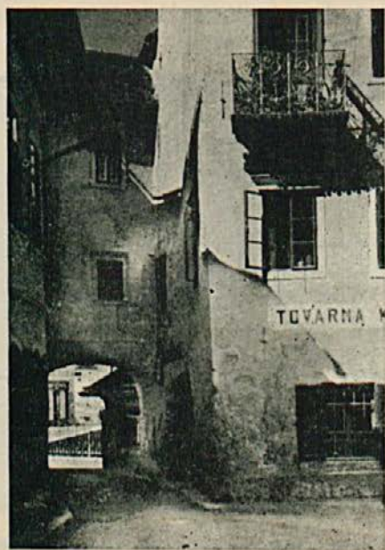
Bivša mestna vrata ob zidanem mostu.
