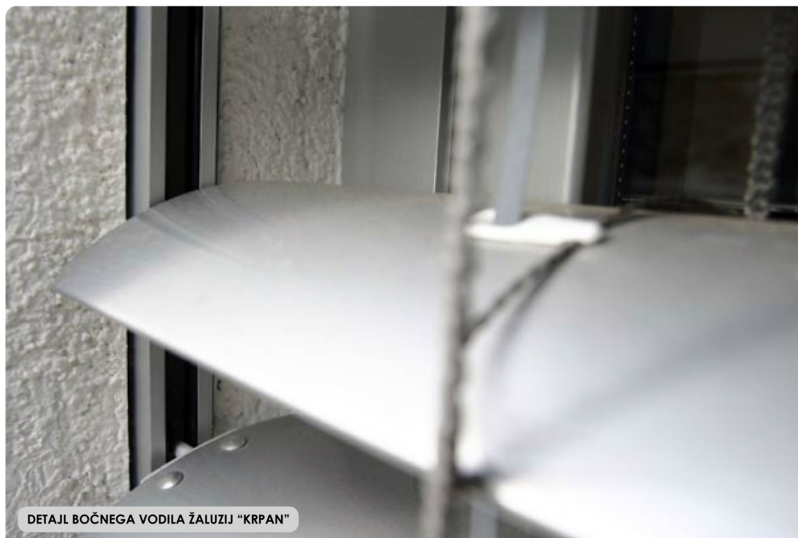
Slika 3.12: Detajl lamel in bočnega vodila venecianskih žaluzij tipa »KRPAN«. Fig. 3.12: Detail of side rail of Venetian blinds, type »KRPAN«.
