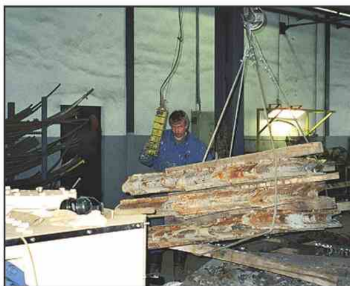
Jekleno podporje je treba večkrat pregledati.
