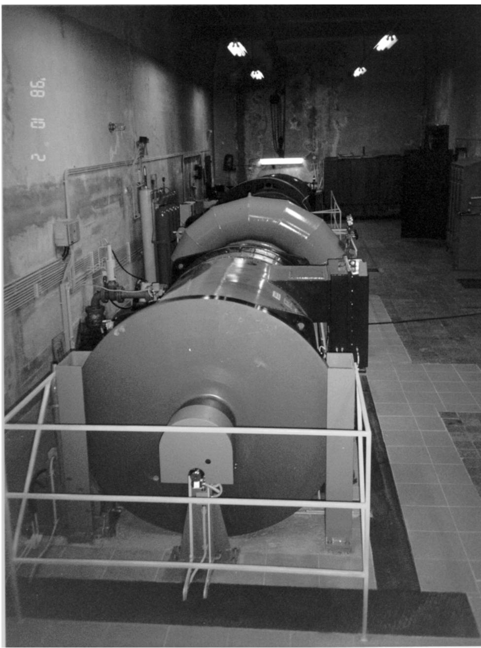
Slika 5. Novi agregat PE1/1 moči 1.45 MW.
