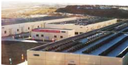
Pogled na stavbo velike kitajske baterije.
