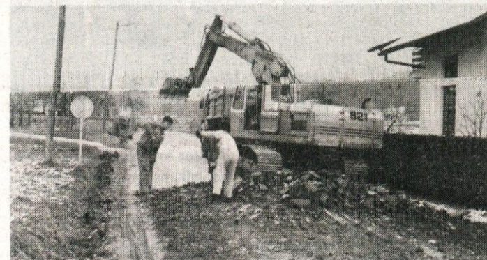
Cesta med gradnjo
