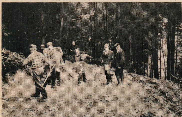
Le z miniranjem se je dalo ponekod nadaljevati začeta dela na trasi novega vodovoda
