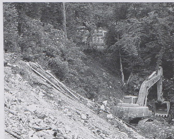
SANACIJA ČRNEGA ODLAGALIŠČA ODPADKOV PRI VAČAH
