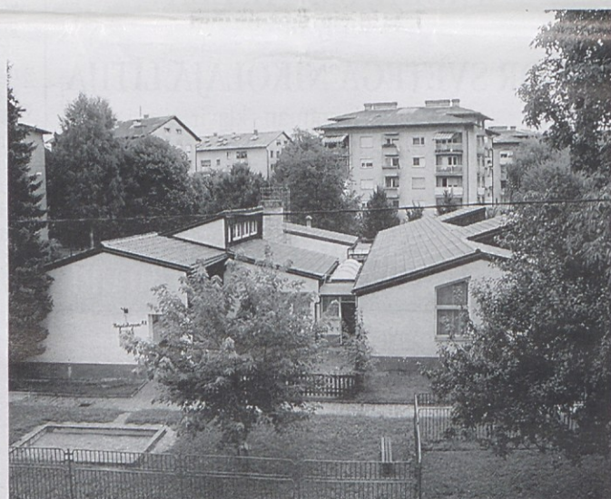
V mesecu juliju so bila opravljena dela pri sanaciji in zamenjavi strešne kritine na objektu vrtca Najdihojca v Litiji. Zamenjano je bilo 750 m 2 strešne kritine in na novo urejena strelovodna zaščita.
