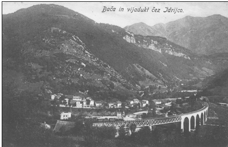
Sl. 1: Bača pri Modreju. Železniški viadukt (Gorica–Jesenice) na razglednici poslani 28. februarja 1915 (avtorjev osebni arhiv). Fig. 1: Bača pri Modreju. Railway viaduct (Gorica–Jesenice), postcard sent on February 28, 1915 (author's personal archives).
