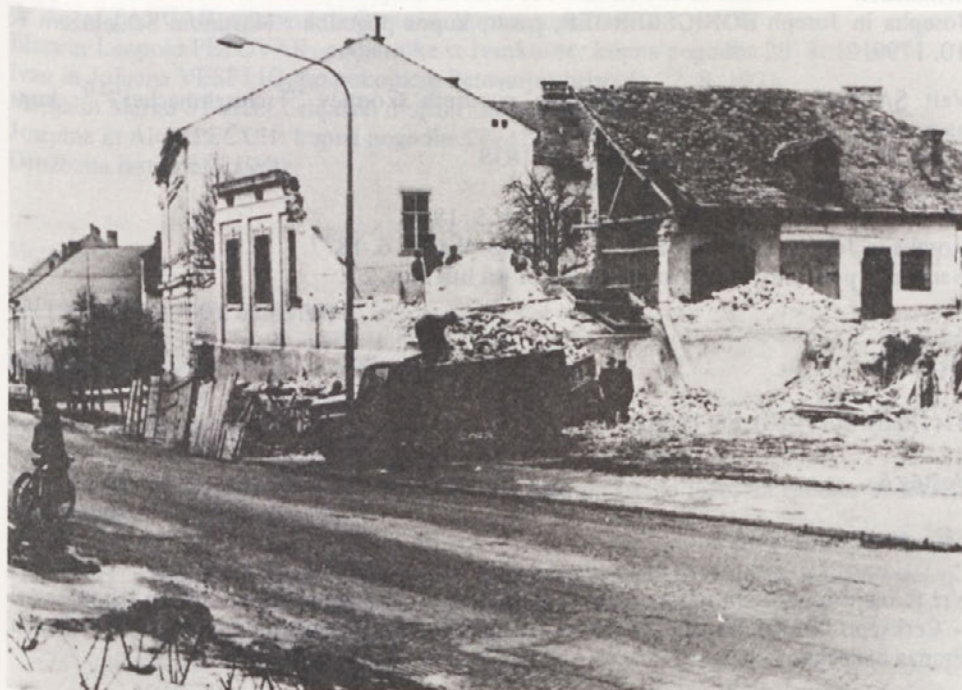
Stare hiše v Ormožu rušijo, 1973. ZAP, Fototeka, neg. 217.
