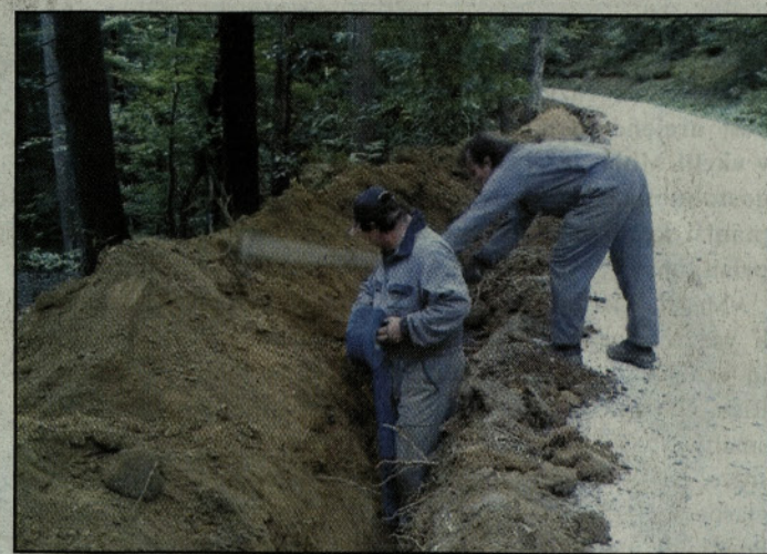
Pri gradnji vodovoda
