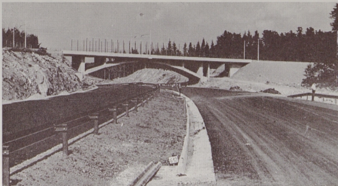
Med obema pasovima hitre ceste bo na sredi, med notranjima odbojnima ograjama, tri metre zelenice
