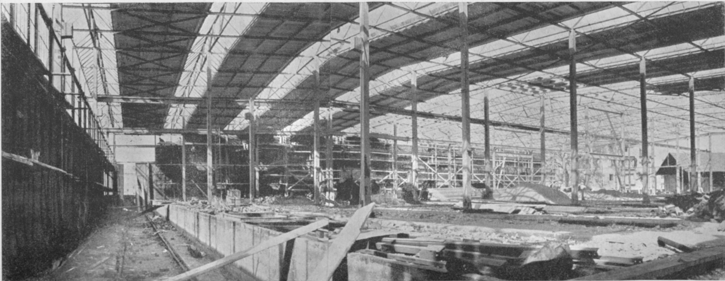
Notranjost skladišča za železo in jeklo
