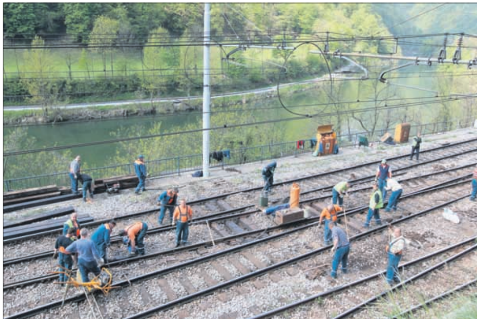
Vzdrževalci so tako pospešeno popravljali in pregledovali tire na kraju nesreče.
