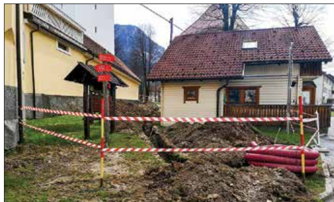
Električne kable, ki so bili do sedaj v zraku, polagajo v zemljo. (Foto: arhiv Občine Gornji Grad)
