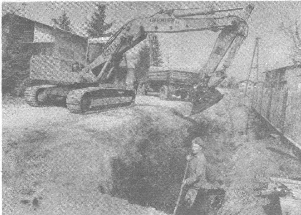
Posnetek je iz Rakove Jelše, kjer delovna organizacija Hidrotehnik čisti in pogloblja odvodne jarke, ki so bili ponekod že prepolni in zaraščeni
